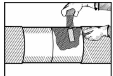
Рис. 4. Нанесение праймера.
